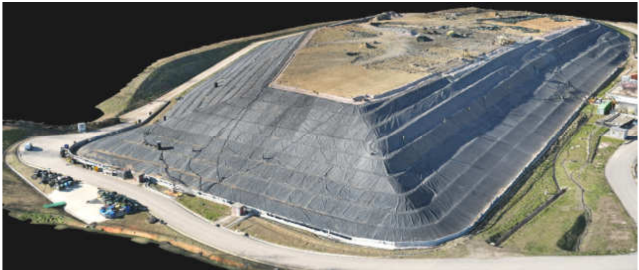
Fig. C - VISTA LATO NORD-EST
