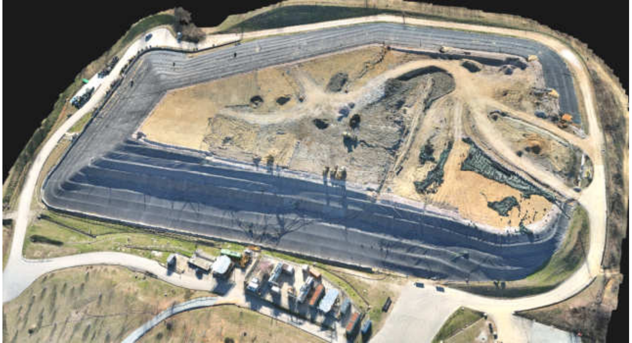
Fig. A - VISTA LATO OVEST
