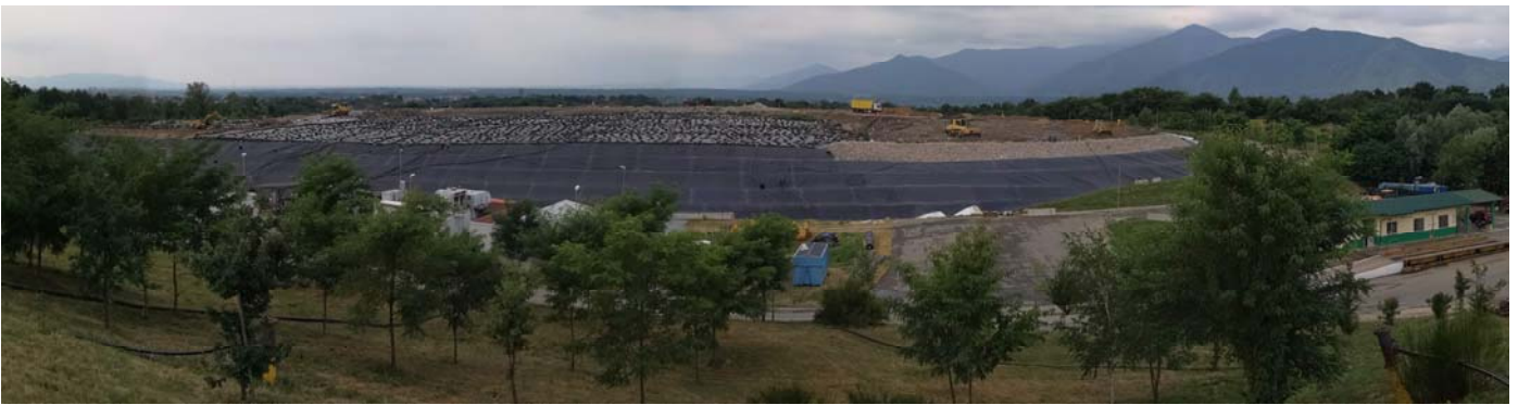
Visione delle lavorazioni del lotto 3 in data 13/07/2022
