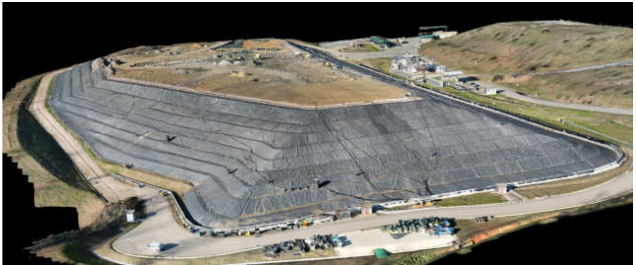
Fig. B - VISTA LATO EST
