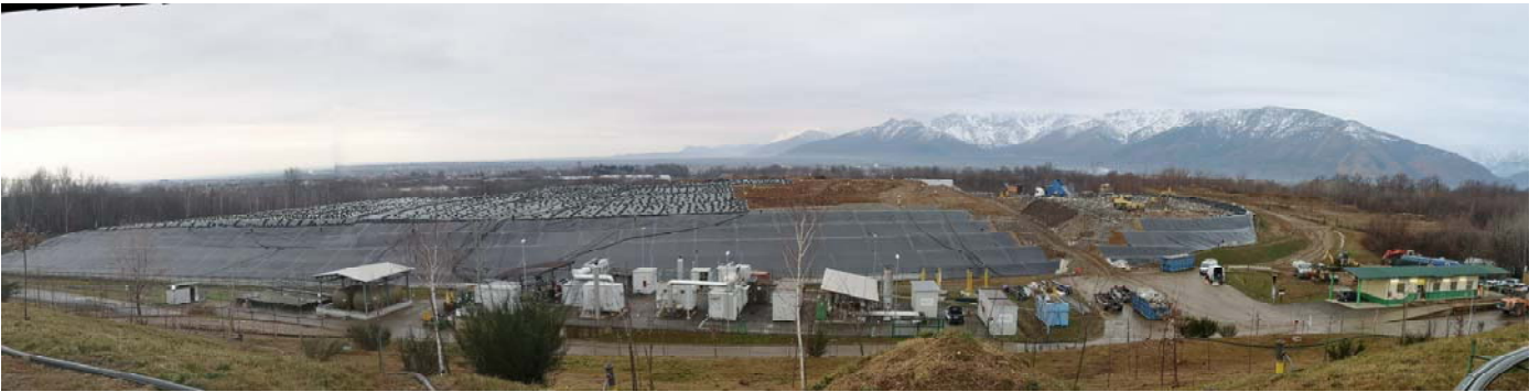
Visione delle lavorazioni del lotto 3 in data 01/02/2021
