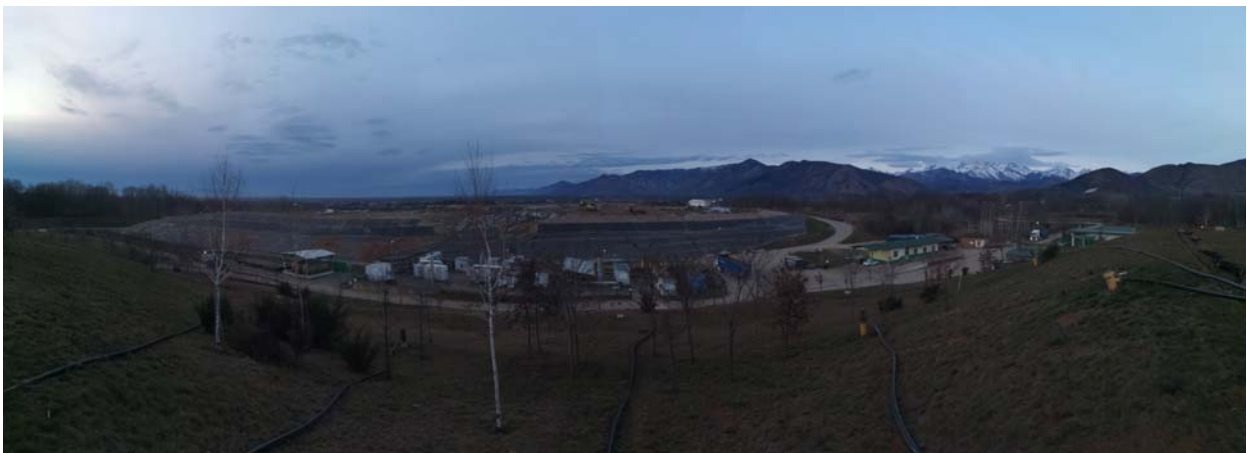
Visione delle lavorazioni del lotto 3 in data 23/01/2023
